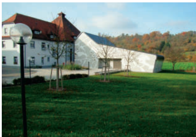
Abb. 3: Außenansicht des Wasserwerks, rechts das Gebäude für die Ultrafiltrationsanlage und die Reinwasserbehälter
