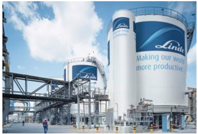
In Leuna (Sachsen-Anhalt) soll die weltgrößte Wasserstoff-Elektrolyseanlage auf PEM-Basis entstehen.
