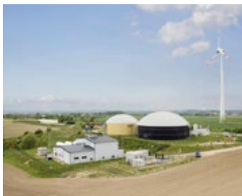
Die Versuche werden an der H 2 -Einspeiseanlage in Prenzlau (Brandenburg) durchgeführt.
