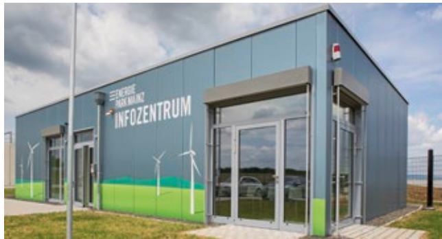
Das Besucherzentrum des Energieparks informiert Besucherinnen und Besucher über die Power-to-Gas-Technologie.
