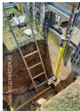
Anbindung der H 2 -Einspeiseanlage an das bestehende Gasnetz
