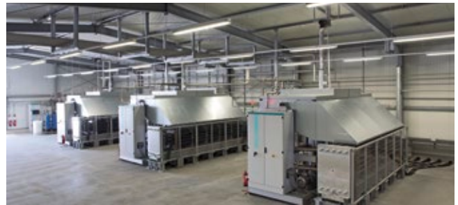
Blick in die Elektrolysehalle, in der insgesamt drei Elektrolyseure Wasserstoff erzeugen.
